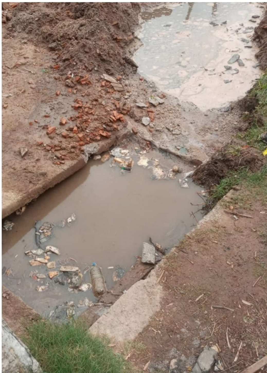
Figura 3 - Caixa de esgotamento pluvial obstruída. Fonte: Moradores Vasco Pires
