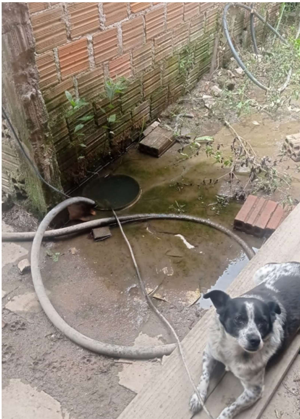
Figura 4 - Caixa esgotamento cloacal obstruída. Fonte: Moradores Vasco Pires
